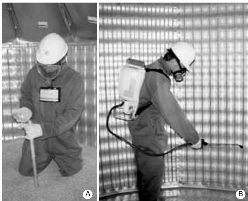
Figure 13. A. Traitement du grain au moyen de comprimés de fumigant; B. Traitement d'un entrepôt vide avec un insecticide de contact. Tel qu'on peut le voir sur les deux photographies, l'opérateur doit porter un masque à gaz recouvrant entièrement le visage, des gants de caoutchouc, une combinaison appropriée et un casque dur.
